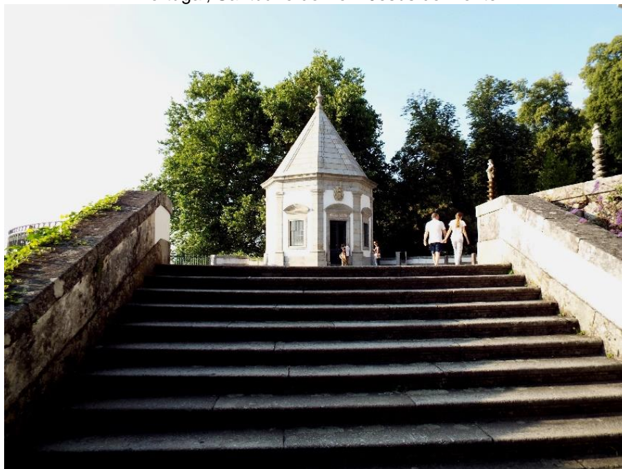
Figura 9 – Final da Escadaria do Pórtico tendo a capela do Caminho do Calvário adiante, Braga, Portugal, Santuário do Bom Jesus do Monte
