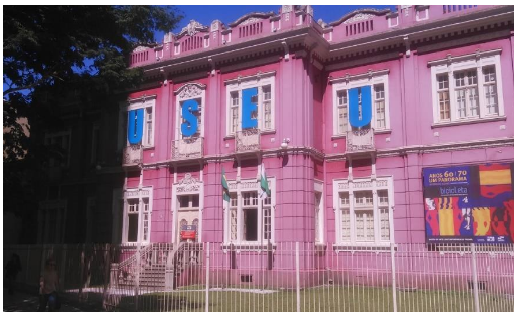
Figura 01. A fachada do MAC-PR.
