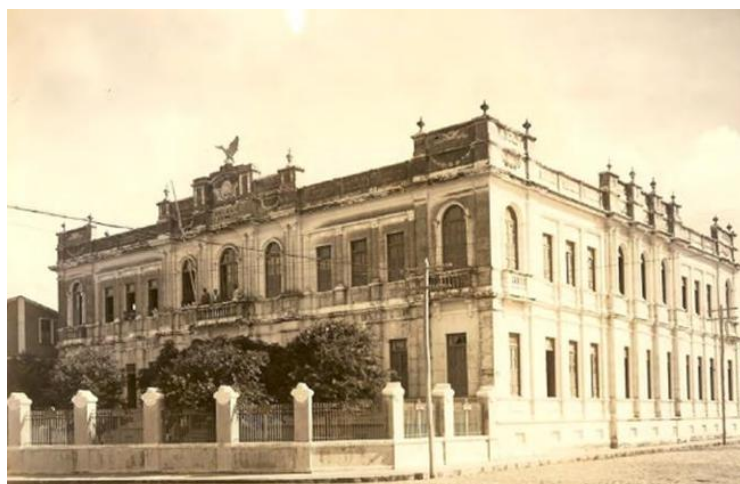
Figura 1 – Vista lateral do antigo prédio do Atheneu Sergipense
