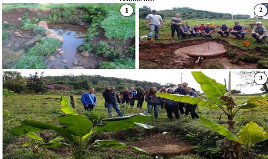
Figura 3 – Projeto proteção de nascente com técnica de solo-cimento, desenvolvido pelas Escolas Estaduais do Campo B, E e F de Quedas do Iguaçu-PR: (1) nascente sem proteção; (2) nascente protegida com técnica de solo-cimento; (3) vegetação plantada no entorno para proteção da nascente.
