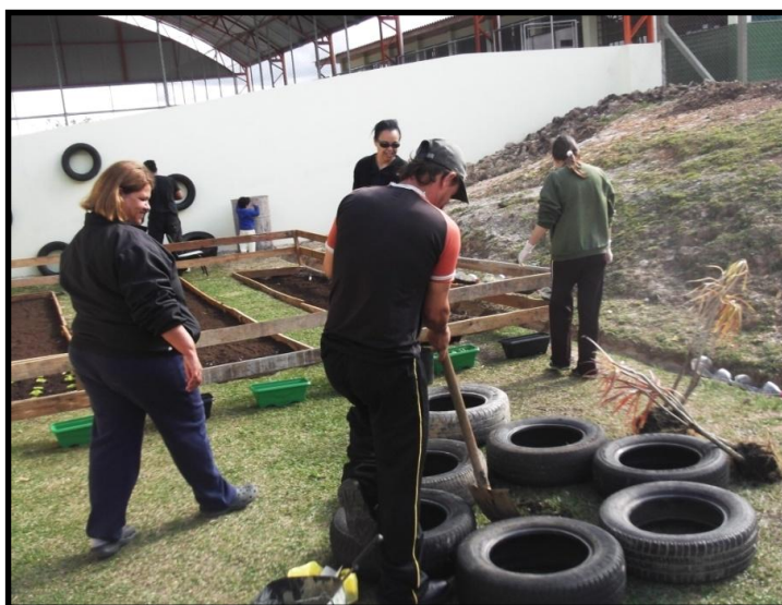
FOTO 02: CONSTRUÇÃO DE CANTEIRO E JARDIM PELA COMUNIDADE ESCOLAR
