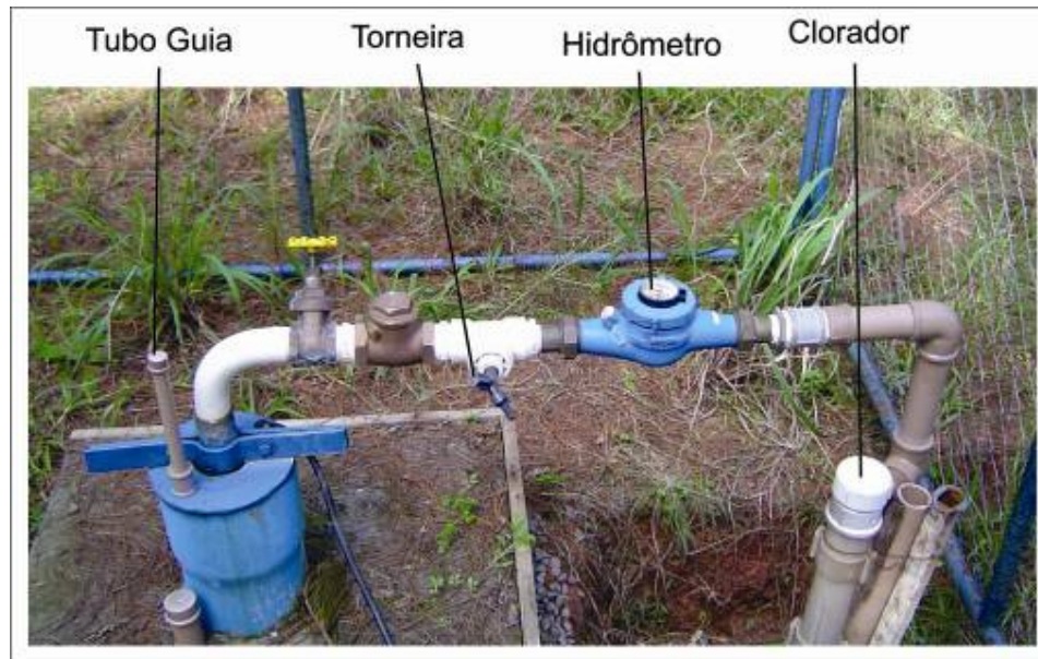
Figura 2. Aspectos construtivos do Poço Estrada do Jardim Botânico (PB 25). Fonte: Arquivo LABHIDROGEO.
