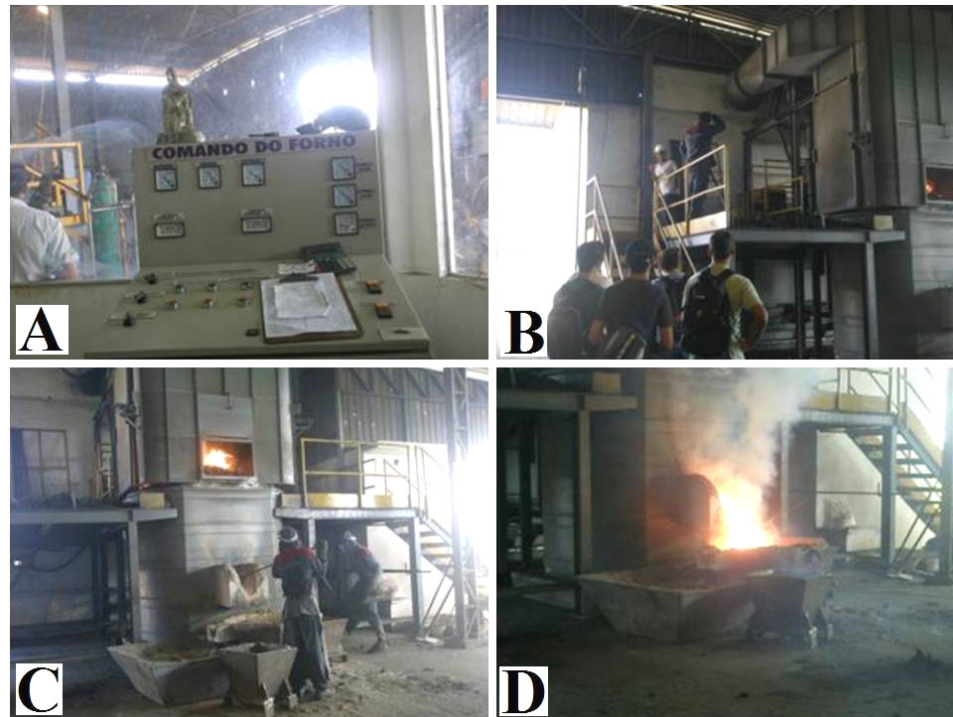
Figura 4. A) comando do forno de fundição; B) escada lateral de acesso aos fornos de fundição; C) forno de fundição; e D) estanho líquido sendo tirado do forno. (Imagens: dos próprios autores)
