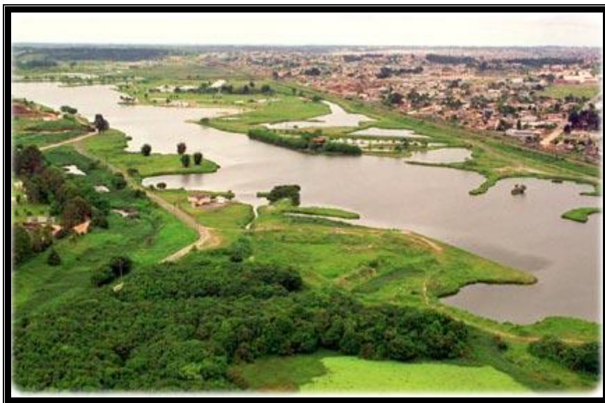
Figura 1: Vista aérea do Parque Municipal Iguaçu.
