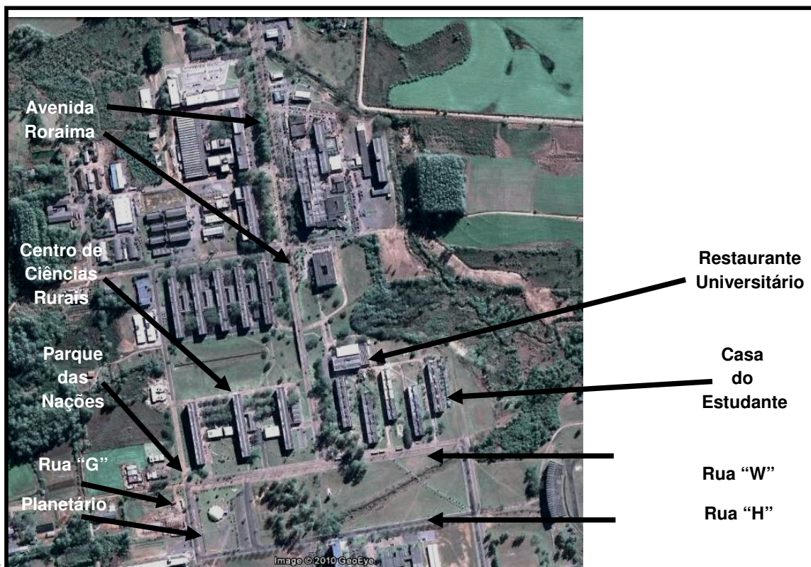
FIGURA 1 – Localização dos pontos levantados, Campus da Universidade Federal de Santa Maria, RS, 2010. Fonte: Google Earth, 2010.
