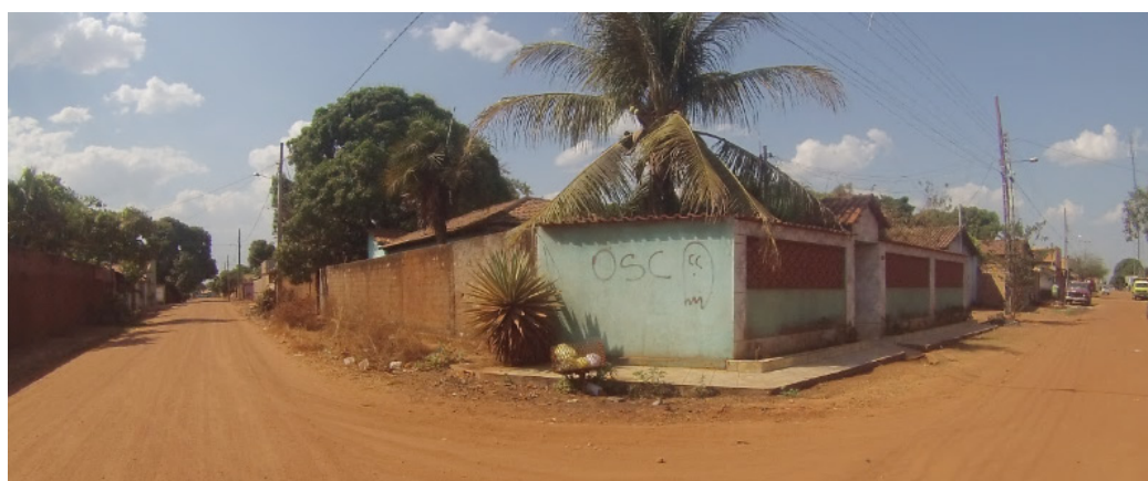
Figura 9 - Situação representativa da ausência de calçadas e pavimentação das vias de locomoção automotivas do bairro Jardim Planalto, Confresa-MT, Brasil
