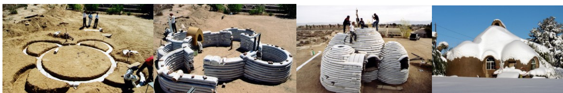
Figura 7: Registros da execução de uma edificação de Superadobe. Fonte: www.calearth.org
