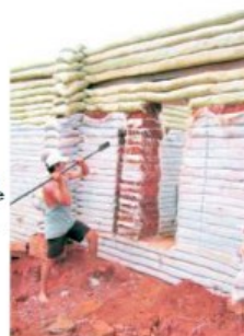
Figura 46 e 47: Construção das aberturas na sede do IMCA, em Montenegro/RS.
