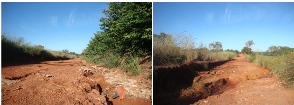
FIGURA 10 – Erosão causada pelo escoamento pluvial advindo do setor Jardim Itaipu na
