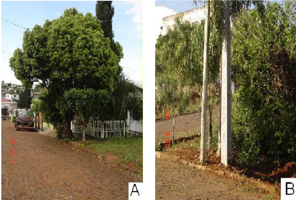
Figura 9 – (A e B) Interferências, causadas na fiação elétrica, por espécies plantadas em locais inadequados.
