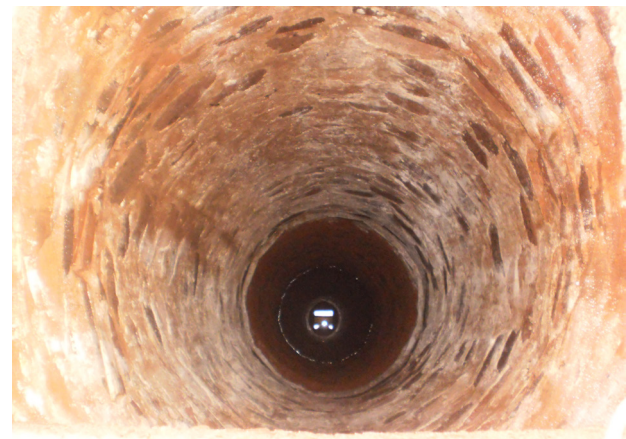
Figura 6 - Poço escavado Bairro Ipiranga, Frederico Westphalen - RS.
