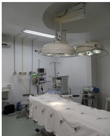
FIGURA 09 - Sala de cirurgia 5 - Hospital B
