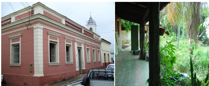
Figura 06 - Residência sede do IPHAN
