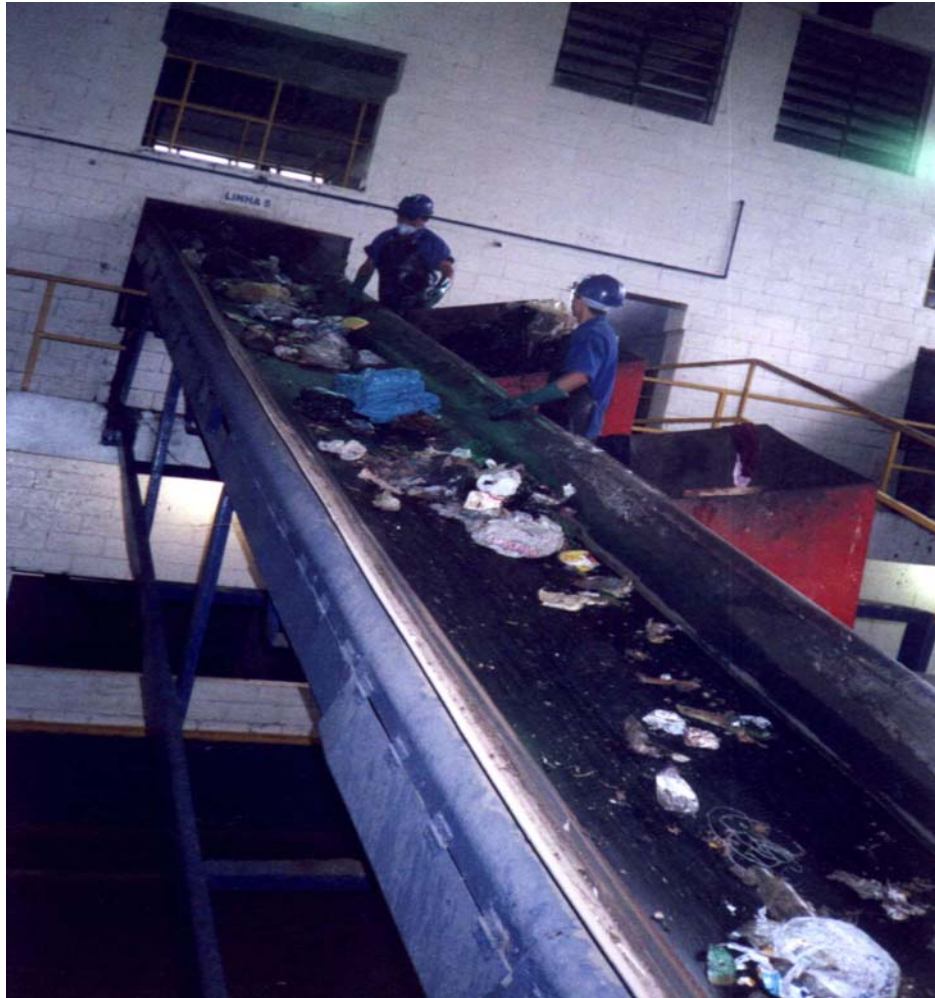
FIGURA 10 - Vista parcial dos equipamentos de processamento de resíduo/lixo da usina de compostagem da Vila Leopoldina - São Paulo
