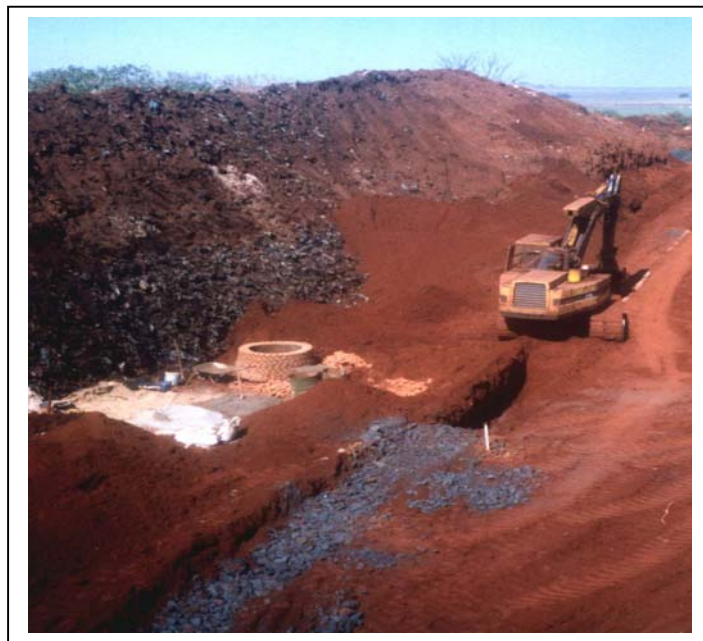
FIGURA 30 - Vista parcial das obras para drenagem de água pluvial em trecho ocupado pela vala de resíduo/lixo
