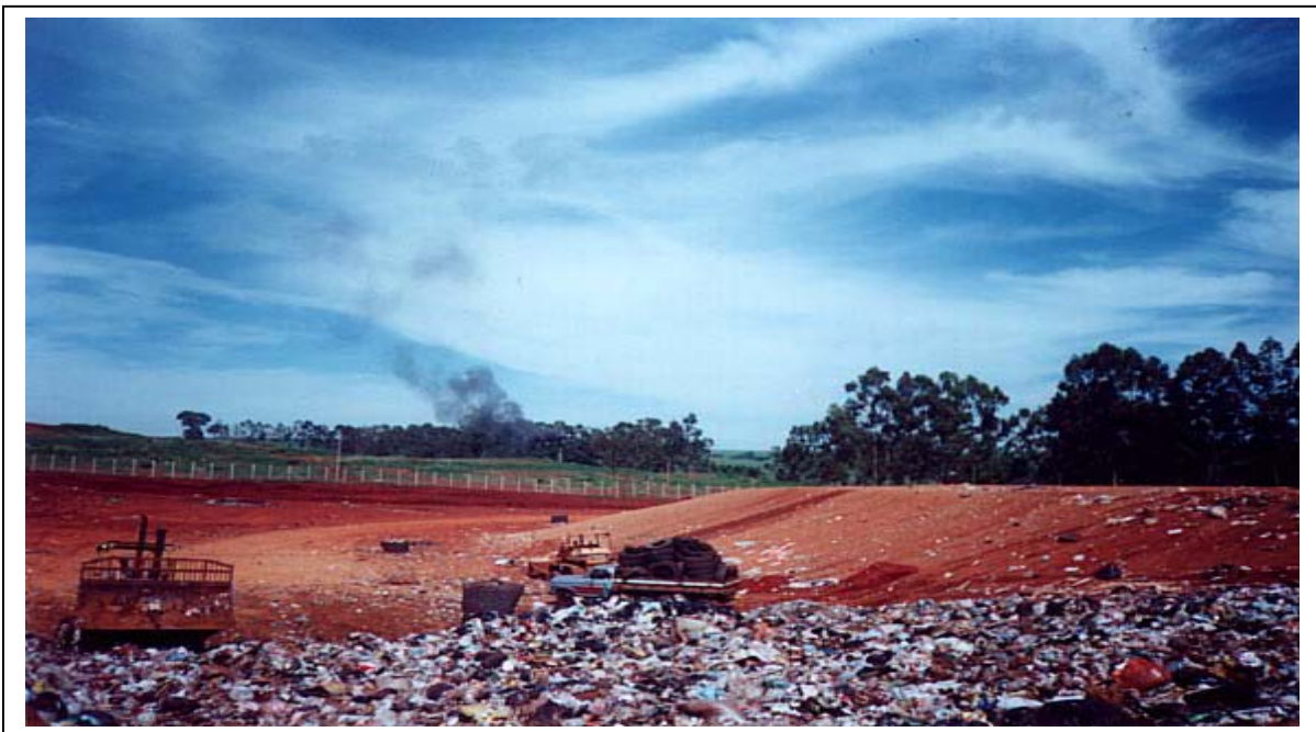
FIGURA 24 - Vista parcial da frente de trabalho do aterro de resíduo/lixo de Ribeirão Preto recepcionando, para codisposição, pneus automotivos usados
