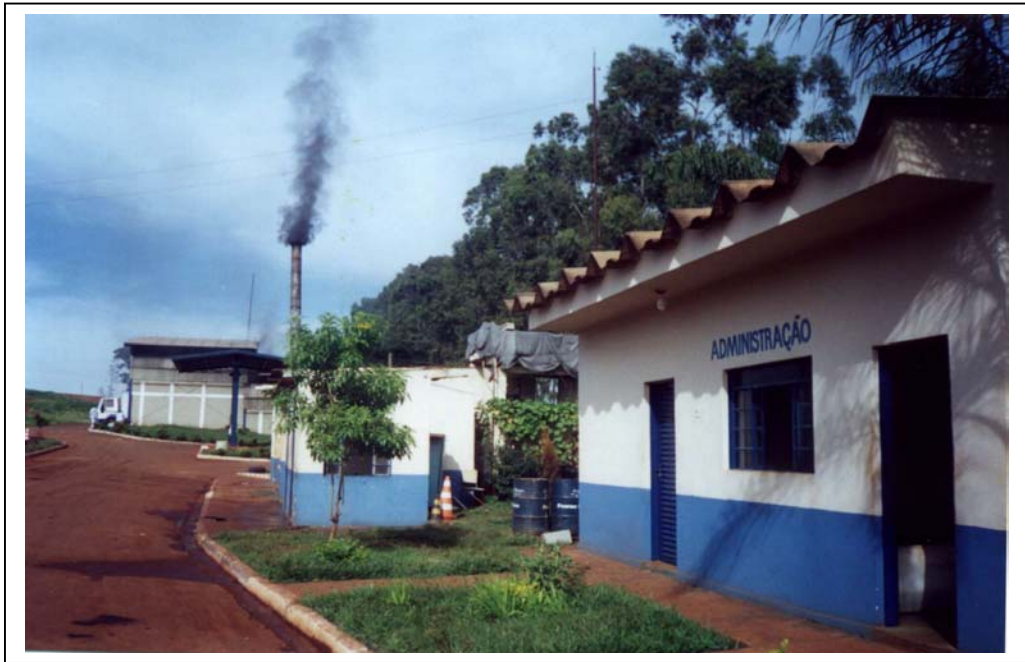
FIGURA 20 - Vista parcial dos prédios da administração do aterro de resíduo/lixo de Ribeirão Preto
