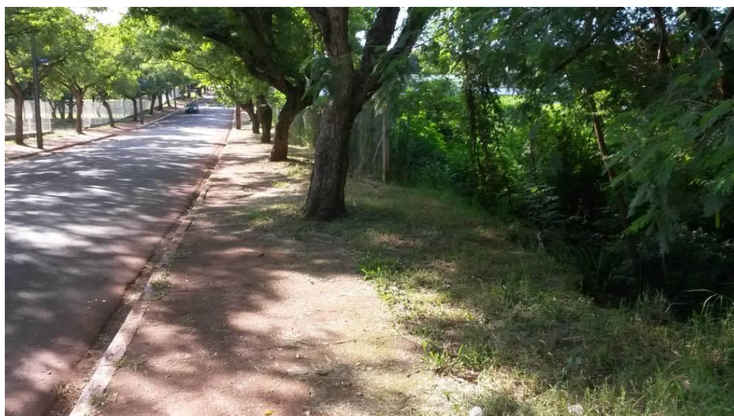
Figura 11 – Processo erosivo próximo à calçada a jusante do parque Alfredo Werner Nyffeler em Maringá - PR Fonte: Autor, 2014
