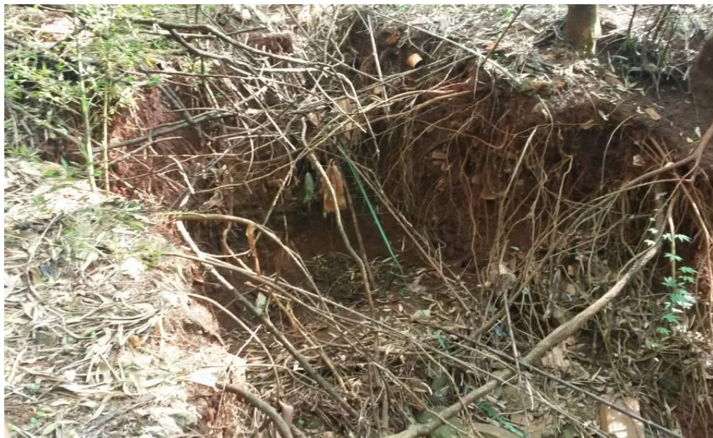
Figura 8 – Restos de resíduos de construção misturados com o terrapleno à jusante do parque Alfredo Werner Nyffeler em Maringá - PR
