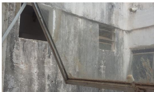
Figura 5 (a) e Figura 5 (b)- Bolores e Eflorescências.
