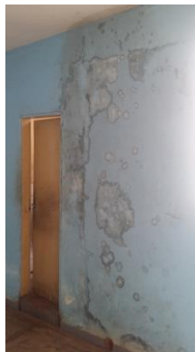
Figura 6- Umidade em área molhada – Banheiro (W.C)
