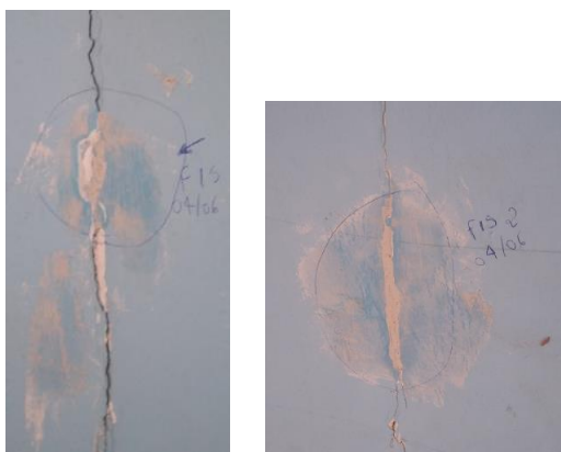
Figura 4- Preenchimento com massa de gesso- (a) Fissura 1 e (b) Fissura 2
