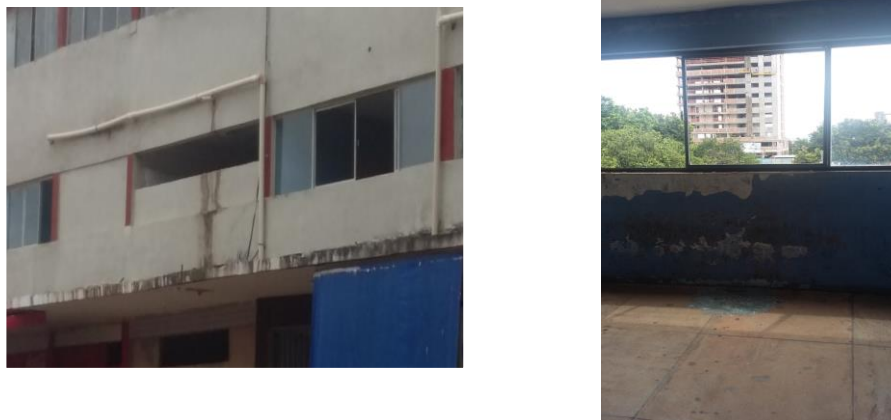
Figura 1 (a)- Formação de bolor na fachada e Figura 1 (b)- Destacamento de revestimento interno.
