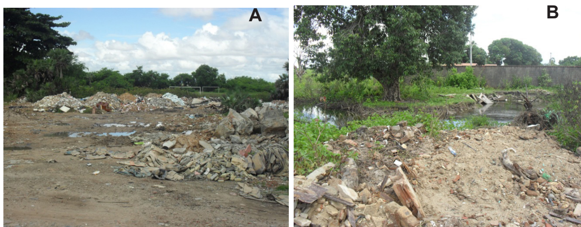
Figura 05 – Aterramentos do mangue para edificações. (A) Aterramento para habitações no bairro Jardim das Oliveiras, (B) Aterramento para edificações no Bairro Salinas (março de 2011).
