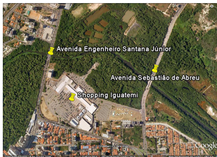
Figura 07 - Avenidas Engenheiro Santana Júnior, Sebastião de Abreu e Shopping Center Iguatemi.
