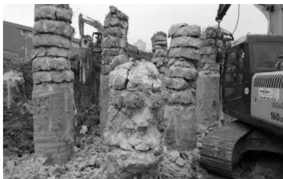
Figura 1- Estacas em processo de demolição.
