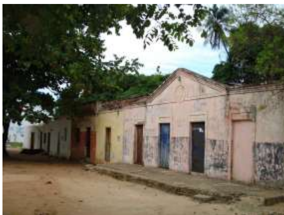
Figura 02: Residências centenárias no município de Horizonte, Ceará. Fonte: Albuquerque (2012). Coordenada UTM_SIRGAS 2000: x=555.939; y=9.550.872.
