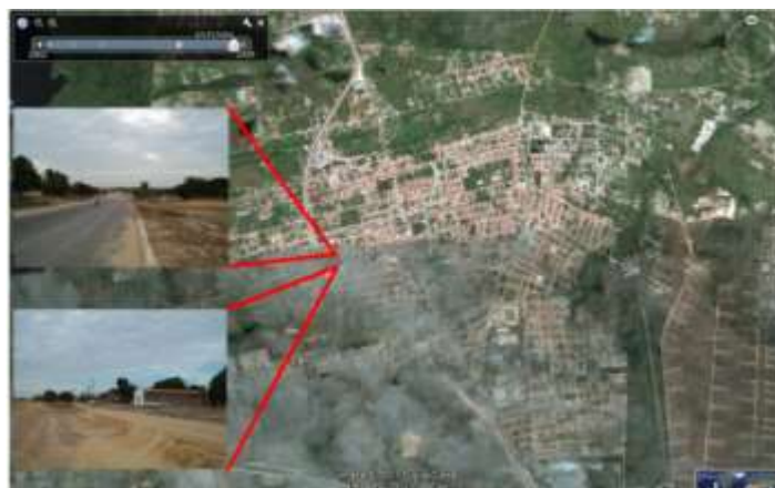
Figura 10: Desvio da Rodovia BR-116 no perímetro urbano de Horizonte, Ceará. Fonte: Imagem Google Earth. Albuquerque (2007/2008). Coordenada UTM_SIRGAS 2000: x=555.150; y=9.546.937.
