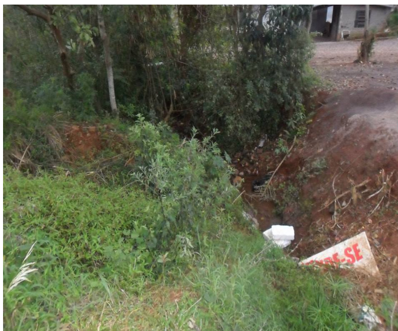
Figura 4: Disposição de resíduos. Fonte: Autor.
