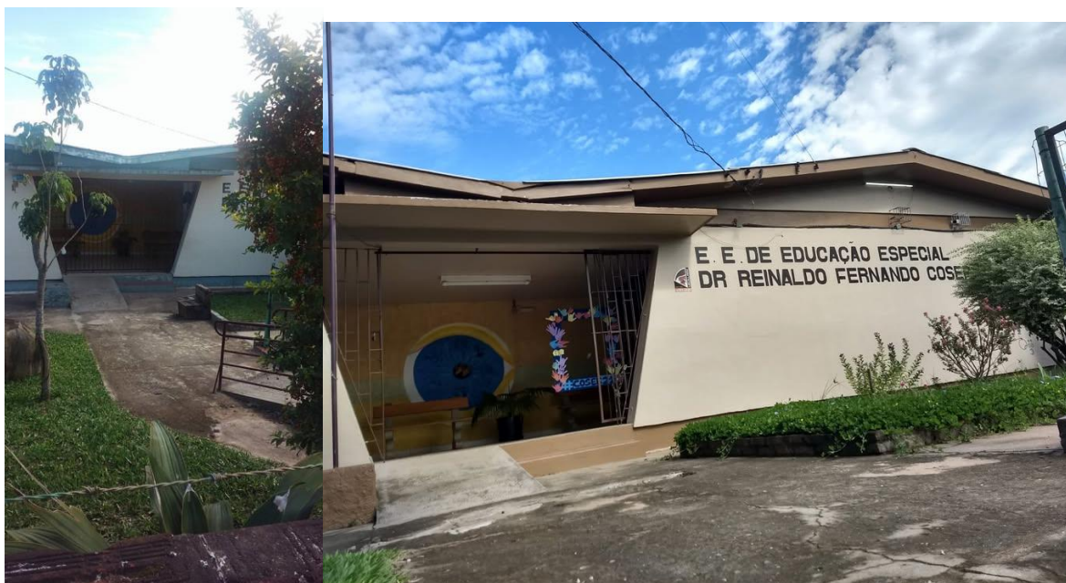
Figura 3 – Escola do ensino fundamental.
