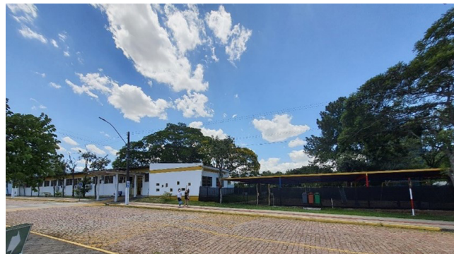
Fotos 26 – Fachada da Unidade com a construção da sala dos bebês à direita, com vazados de vidros na parede. Fonte: Foto da autora.
