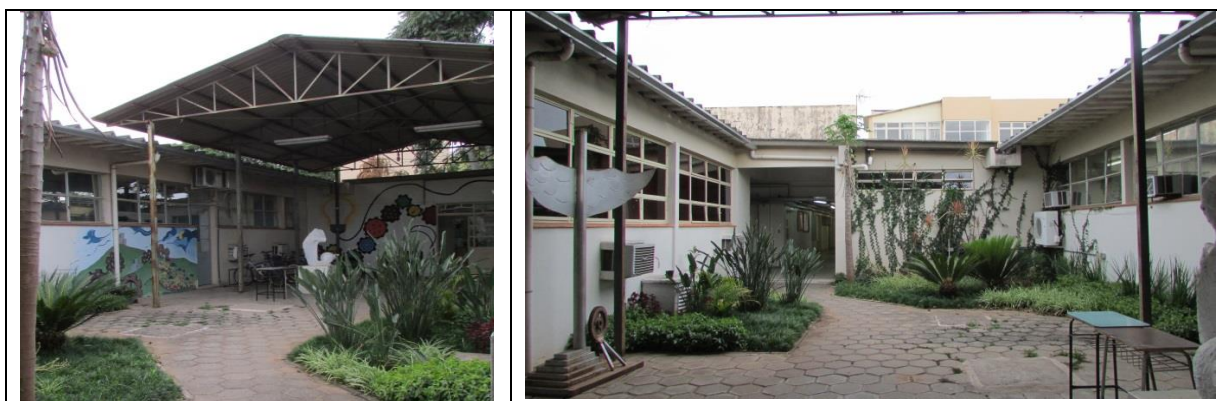
Figura 23 - Pátios internos a edificação.
