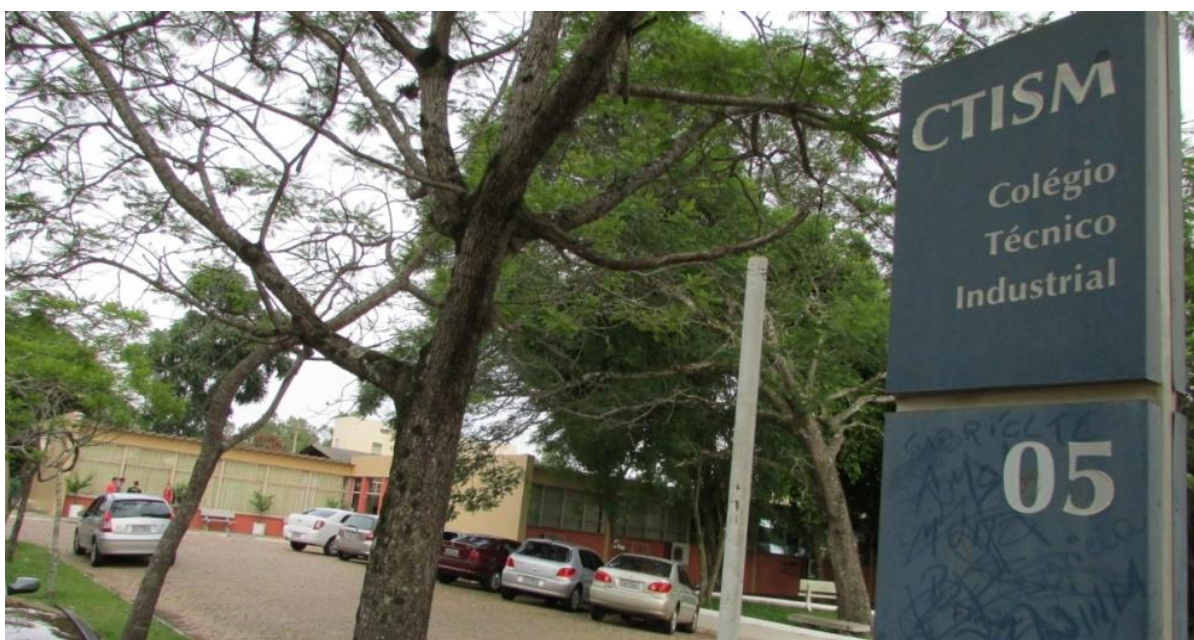
Foto 15 - Edificação do Ctism.
