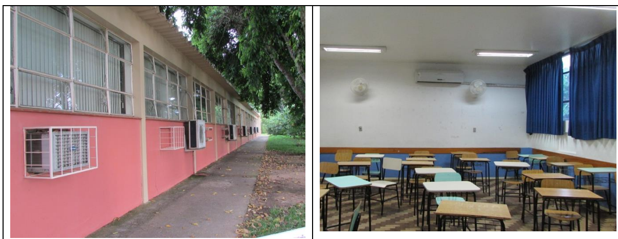
Figura 16 - Salas do Ctism condicionadas artificialmente.
