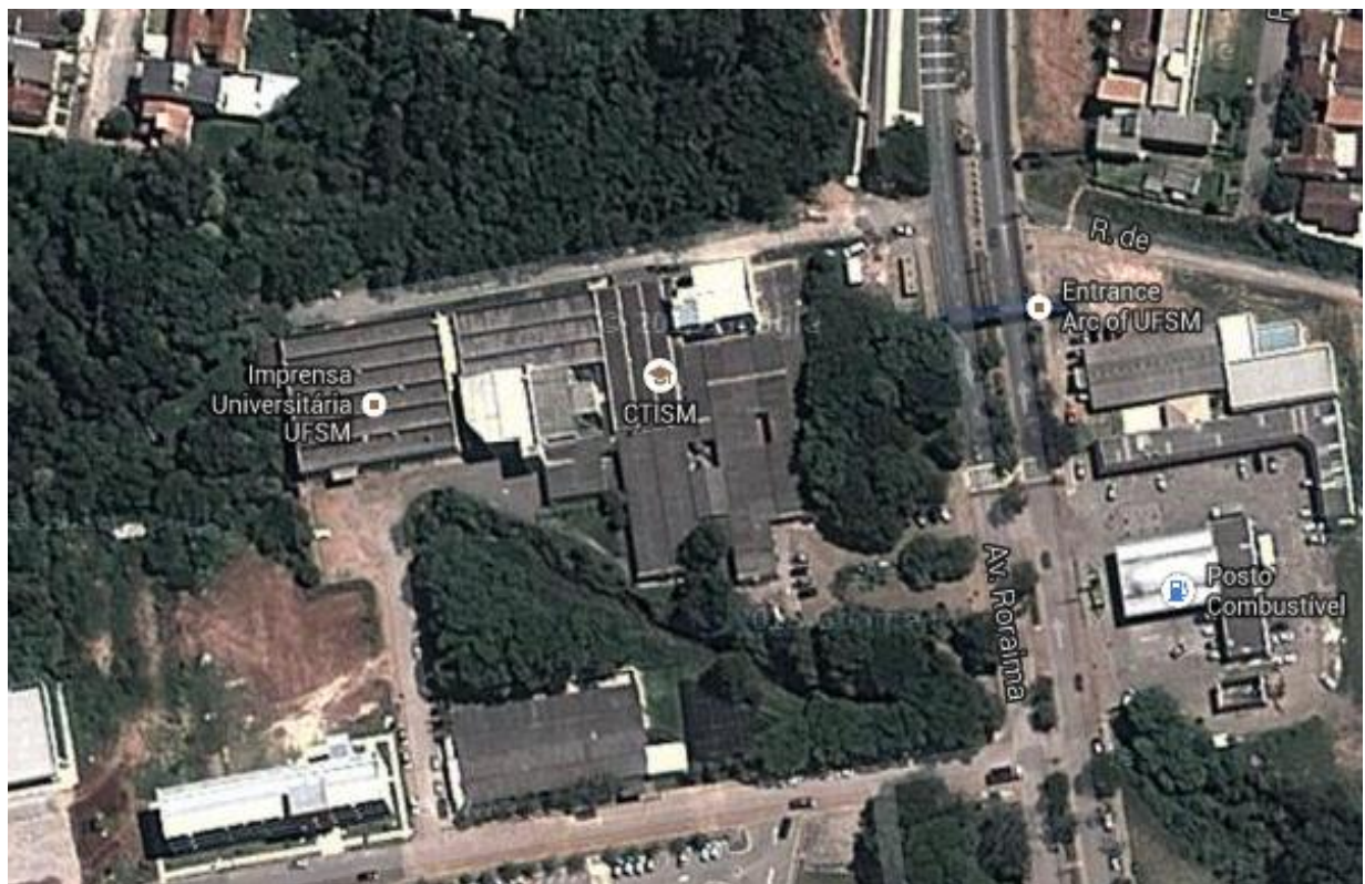
Figura 14 - Vista aérea da edificação ( www.googlemaps.com ).
