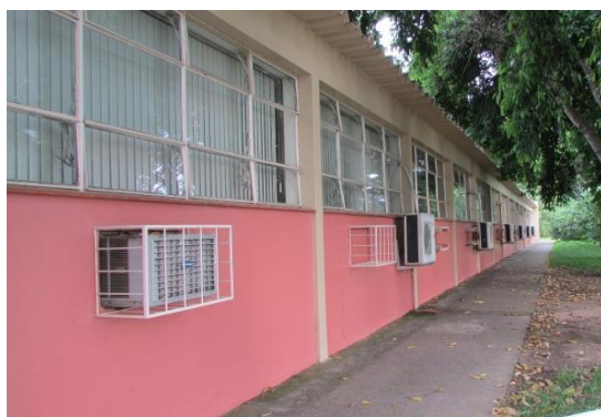
Figura 18 - Fachadas voltadas para o Leste.
