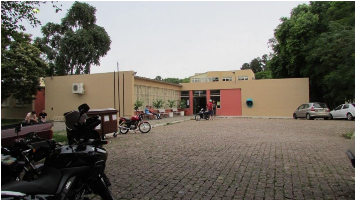
Figura 17 - Fachadas voltadas para o Sul.
