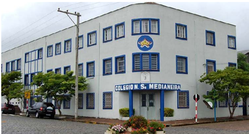
Figura 1 -Fachada do Colégio Medianeira
