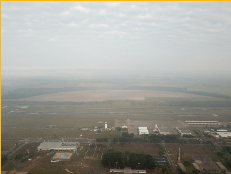
Figura 4 – Imagem de ancoragem de Avaliação da Visibilidade Oblíqua Operacional – N3
