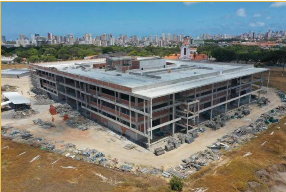
Figura 7 – Obras do novo campus do ITA em Fortaleza
