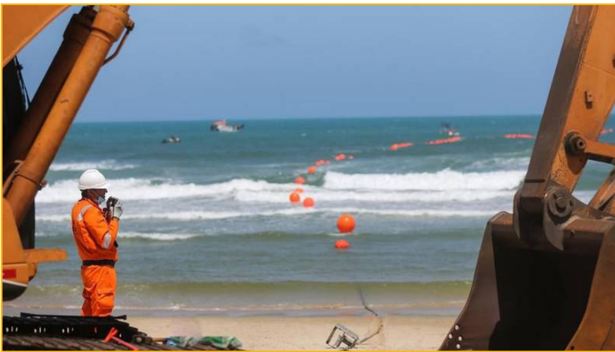
Figura 2 – Lançamento de cabo submarino na Praia do Futuro, em Fortaleza
