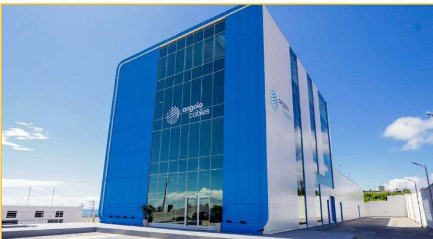
Figura 3 – Novo Data Center da empresa Angola Cables, na Praia do Futuro
