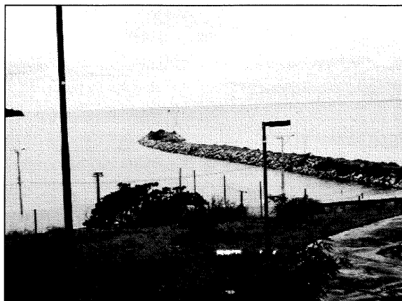
Foto 01 – Espigão construído para conter erosão na praia. Fonte – Dados de pesquisa.
