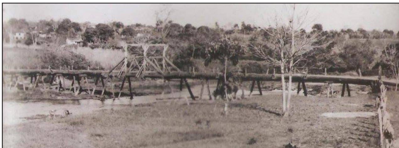
Figura 3 – Primeira ponte sobre o Rio Claro para o acesso a cidade de Caçu, construída em 1950
