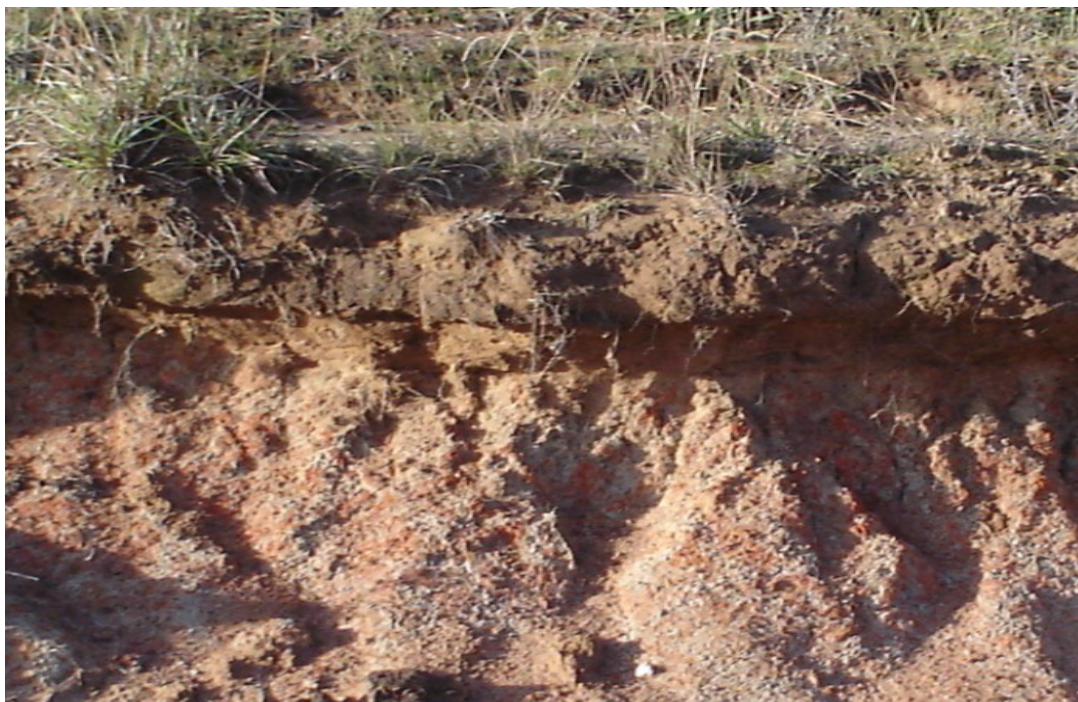
Figura 6 - Aspecto de um corte de estrada deixando à mostra o perfil do solo onde ocorre um plintossolo.
