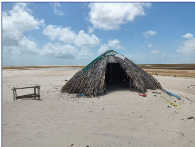
Figura 8 – Carutos - ranchos de pesca local, construídos com palha e madeira
