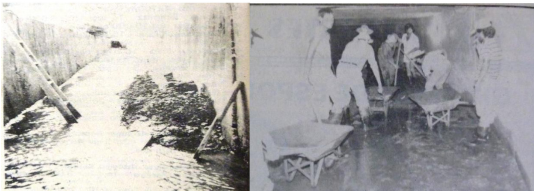
Figura 6 - Limpeza de trecho com canalização aberta (esquerda) e fechada (direita).
