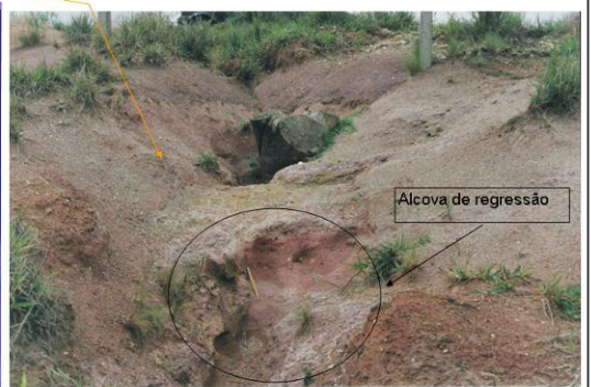
Foto 8 - Erosão 2 - ravinas profundas Fonte: acervo do autor, 2005.
