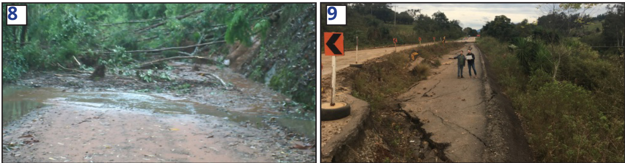
Figuras 8 e 9 – Estrada interrompida por deslizamento em 2010 e rebaixamento de talude na rodovia RS149 em 2015
