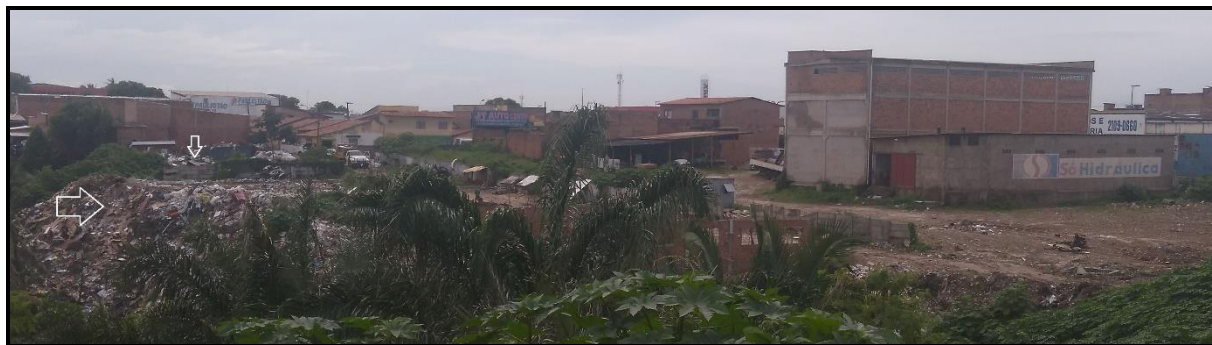
Figura 6 – Aterro irregular de resíduos sólidos
