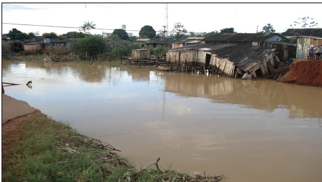
FIGURA 1: Desmoronamento de casas em palafitas no igarapé Altamira no dia 12 de abril de 2009. Foto de Germano Leitão de Oliveira Junior.
