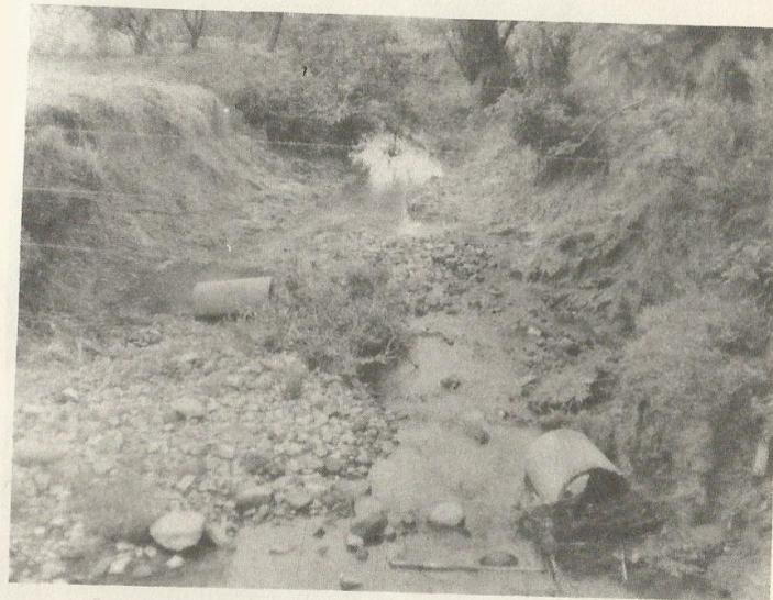
FOTO 6 - Ponto crítico do assoreamento no leito fluvial.
