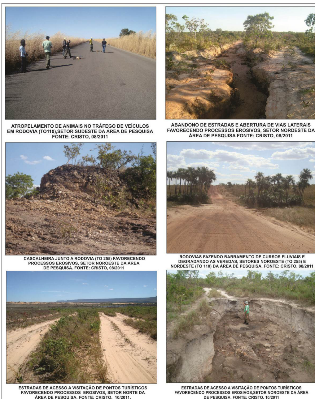
Figura 4 – Interferências ocasionadas pelas rodovias que passam na área de pesquisa. Fotografias: Autores, 2011.
