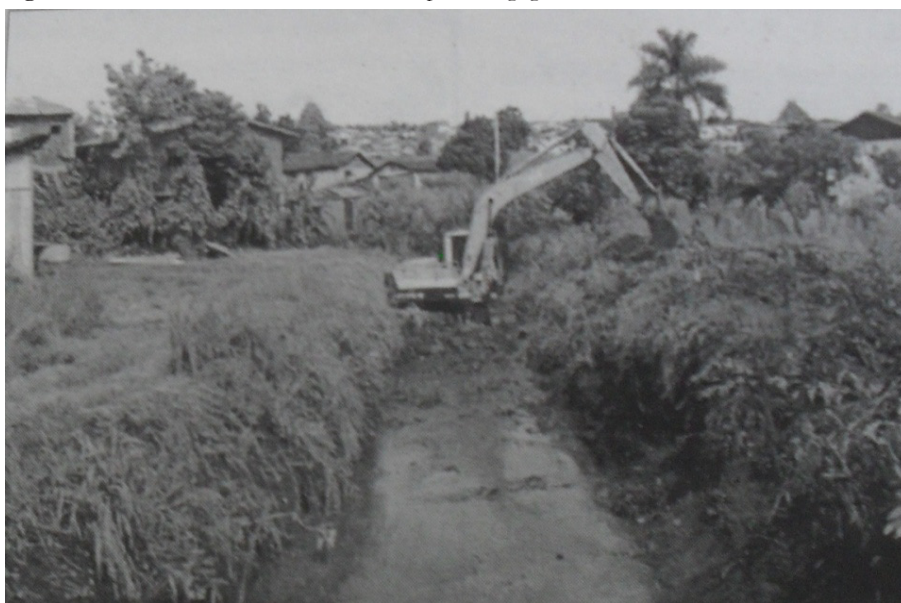
Figura 7 - Escavadeira hidráulica utilizada para dragagem de rio urbano.
