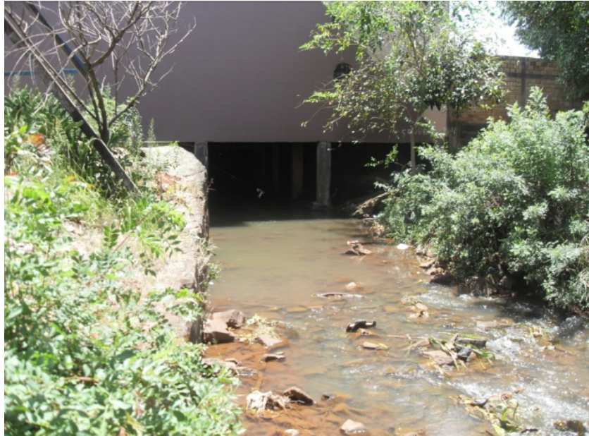
Figura 9 - Trecho com canalização fechada imediatamente abaixo de prédio no Lajeado Passo dos Fortes.
