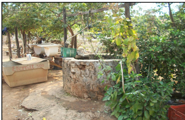
Figura 3 - Poço monitorado nº 10, sem proteção.
