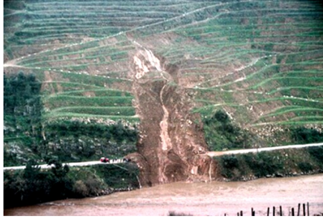
Foto 1 — Movimento em massa numa vertente de “vinha em patamares” afetando uma estrada na região da RDD.
