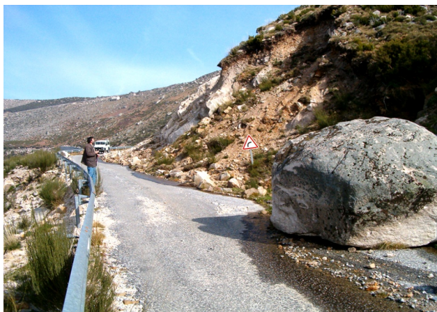
Foto 4 — Rodovia na Serra da Estrela afetada por diversos processos de evolução de vertentes que afetaram a sua estrutura. Note-se nas vertentes regularizadas por diversos tipos de formações superficiais.
