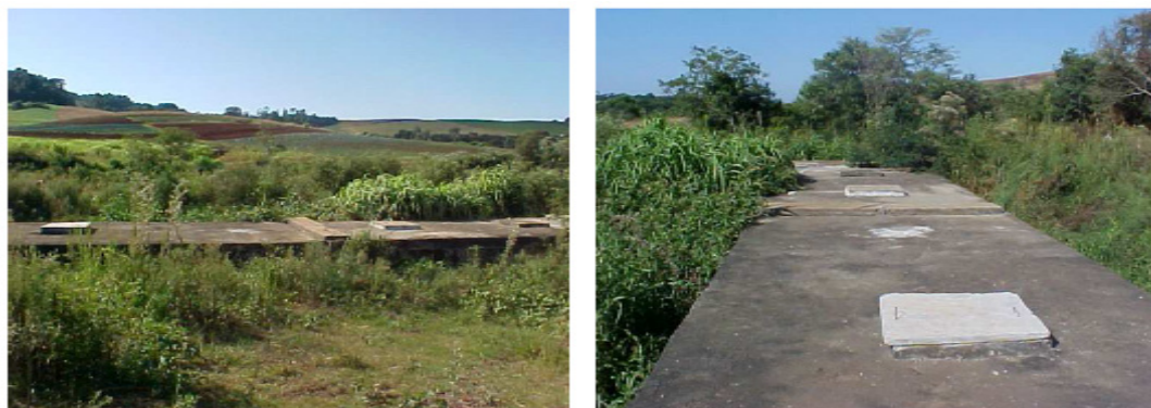
Figura 2 – Estação de tratamento de esgoto no bairro Vila Rica em área de banhado
