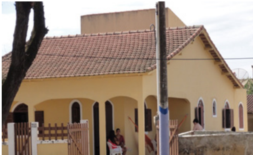
Figura 10 – Segunda residência (Fevereiro 2013).
