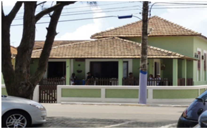
Figura 9 – Segunda residência (Fevereiro 2013).
