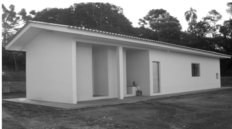
Figura 1 – Unidade de extração de mel em propriedade apícola de Prudentópolis
