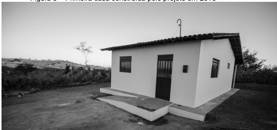
Figura 3 – Primeira casa construída pelo projeto em 2016
