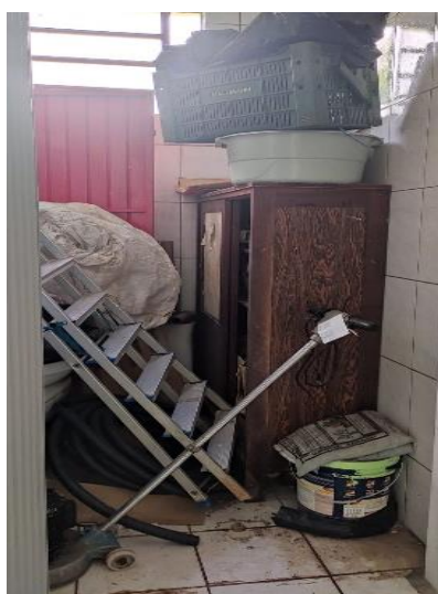
Imagem 4 – WC acessível da escola D, usado como depósito
