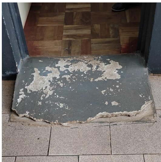
Imagem 5 – Rampa de acesso da sala
