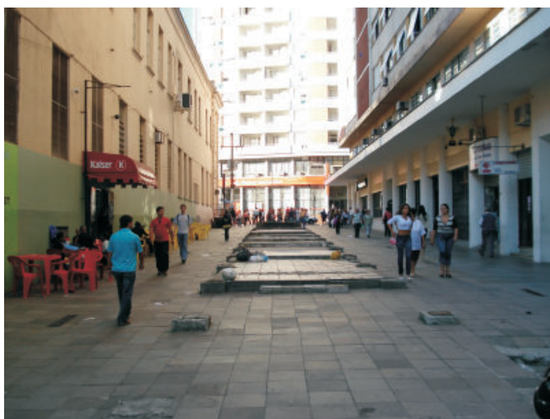
Figura 6. Fotografia da Antiga Rua 24 Horas no sentido oeste/leste retratando a falta de limpeza e manutenção.
