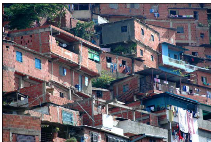
Figura 2. Fotografia de detalhe de ocupação em encosta/RJ.
